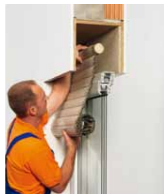
Alten Rollläden aus dem Kasten entfernen.
