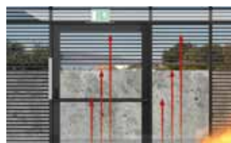
ROMA Schnellraffung – Mit dem neuen akkugestützten Schnellraffsystem fahren Raffstoren in Gefahrensituationen blitzschnell nach oben. (Auch bei Stromausfall)
